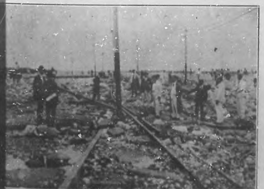
En el Vedado, donde los estragos demostraron con mayor evidencia la furia del mar fué sobre los tendidos de los tranvías en la línea del Vedado, sobre la que cayeron inmensas moles del muro del Malecón, levantando los rieles y retorciéndolos como puede observarse en las adjuntas fotografías.
