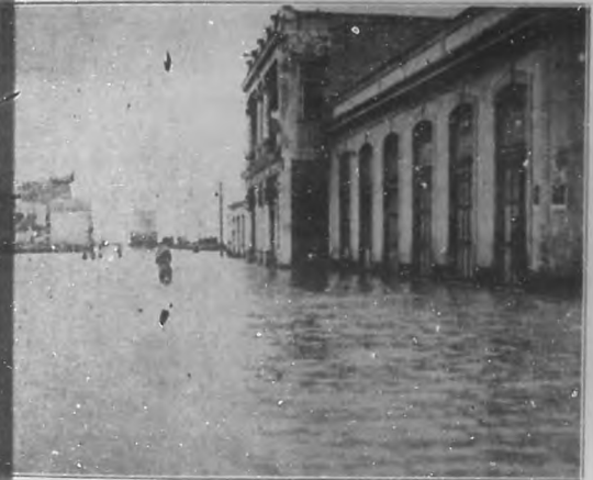
El hermoso paseo del Malecón, el agua penetró con furia arrasadora cubriendo todos los espléndidos edificios que se levantan gallardos frente al mar.
